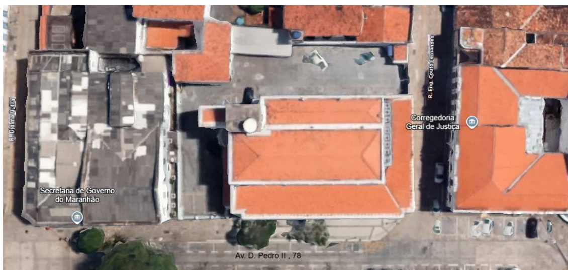
Figura 01 – Indicação do prédio onde será implantado o Data Center . Av. D. Pedro II, No. 78 - Fundos.
