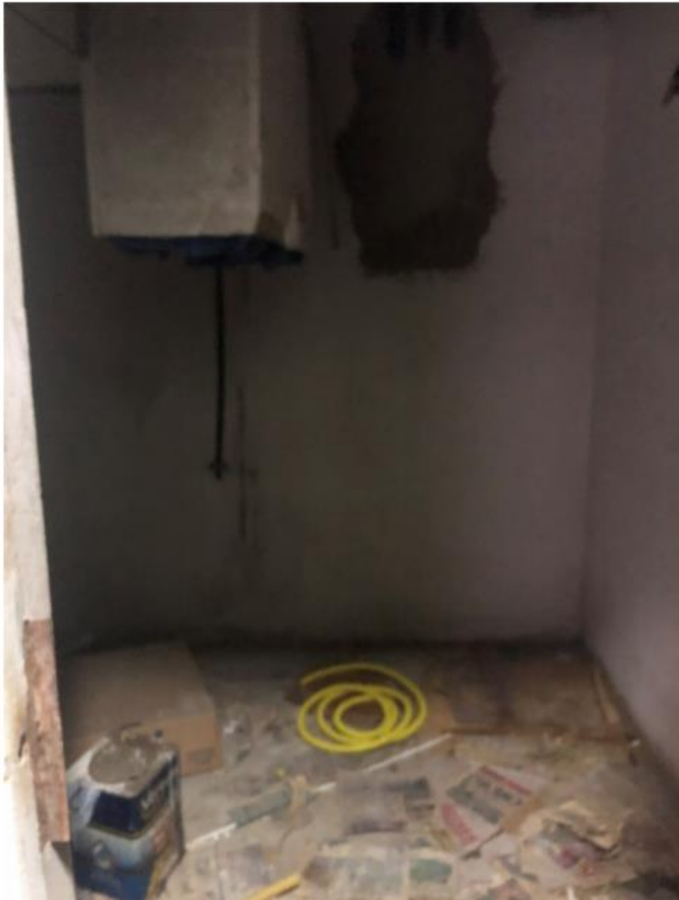
Foto 04: Local de Instalação do gerador de 240 kVA.
