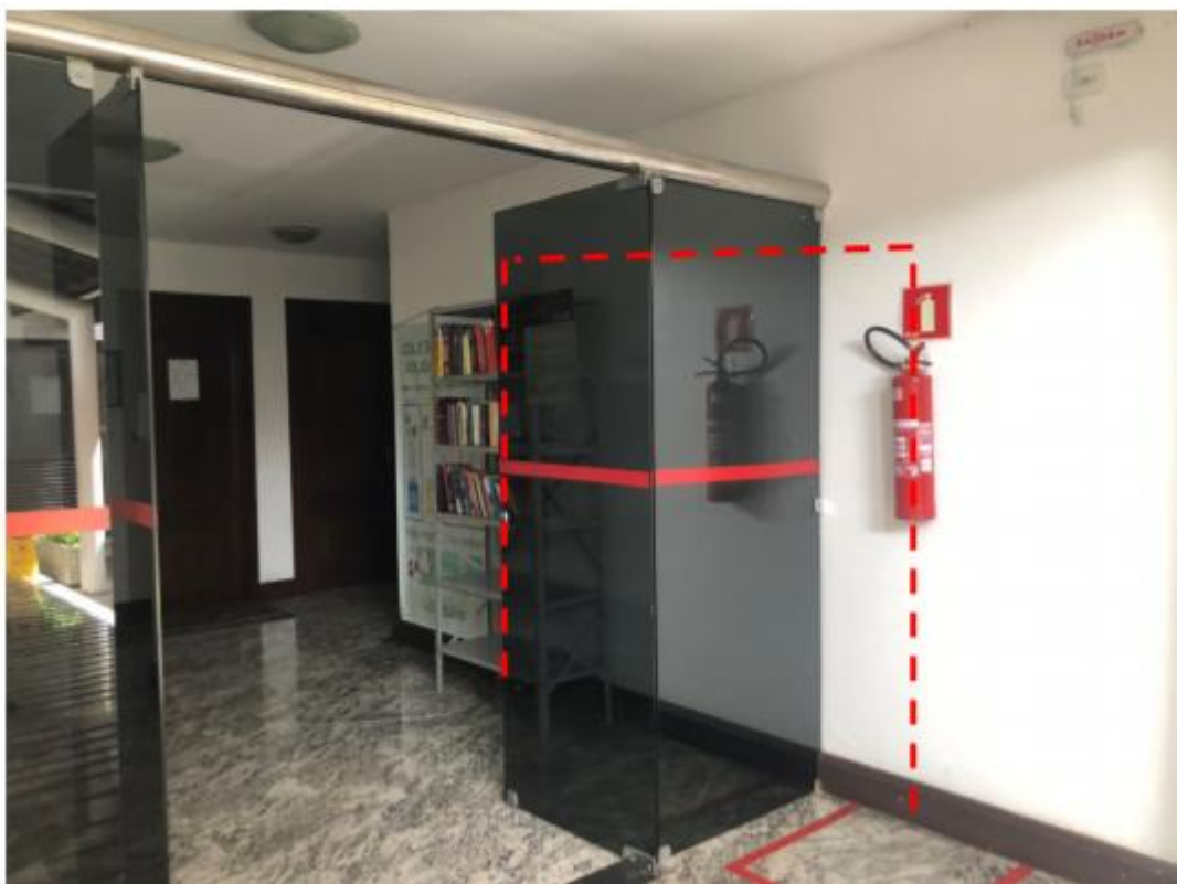
Foto 05: Local de passagem do gerador de 240 kVA.
