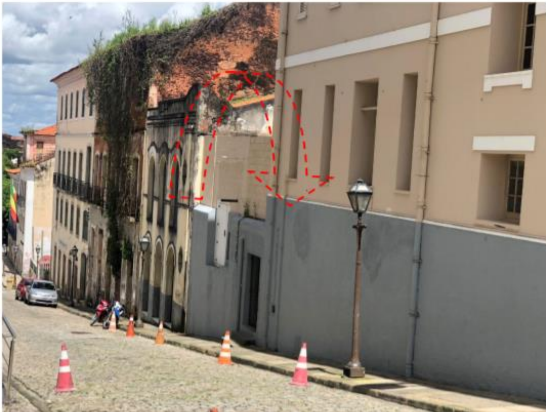
Foto 03: Local de entrada do gerador de 600 kVA (provável uso de caminhão munck)
