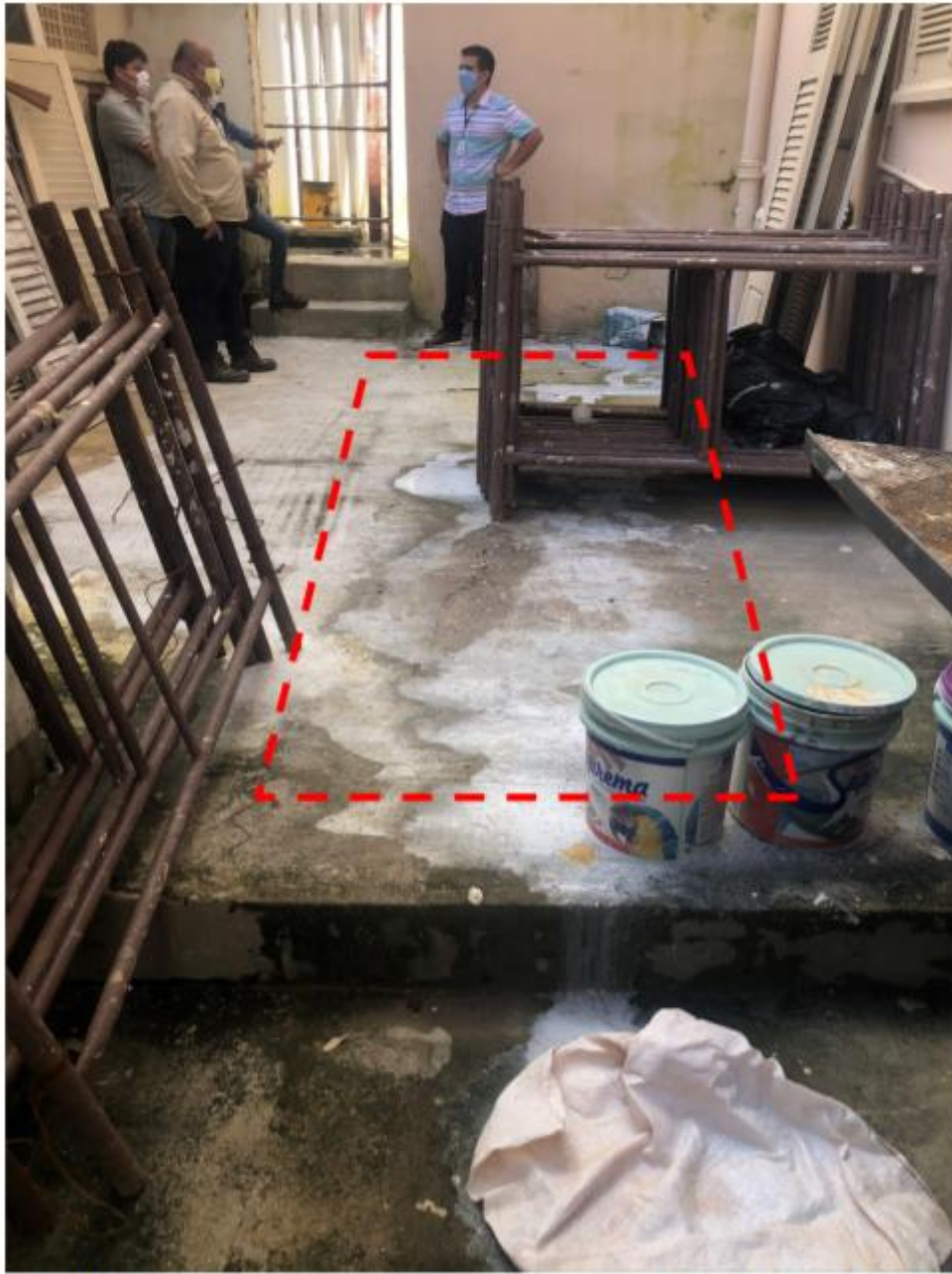
Foto 02: Lugar de instalação do gerador de 600 kVA.
