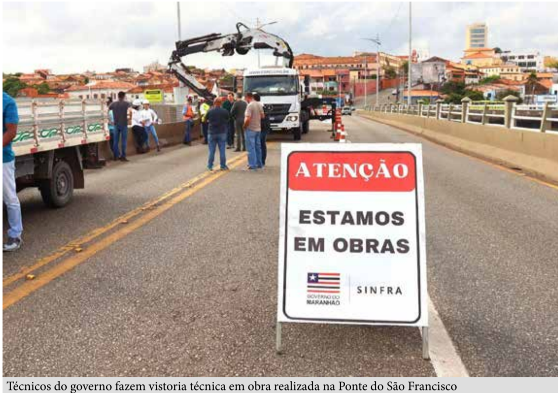
Técnicos do governo fazem vistoria técnica em obra realizada na Ponte do São Francisco
