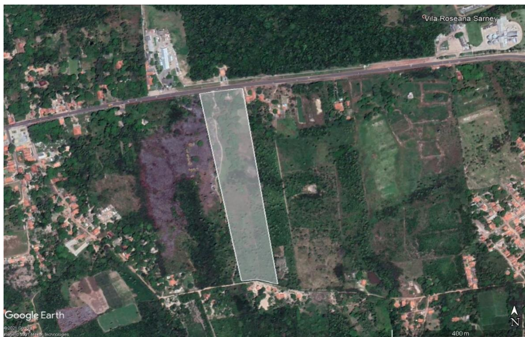
Figura 8 - Acesso à área da Usina Solar Distrito São José de Ribamar - MA.
