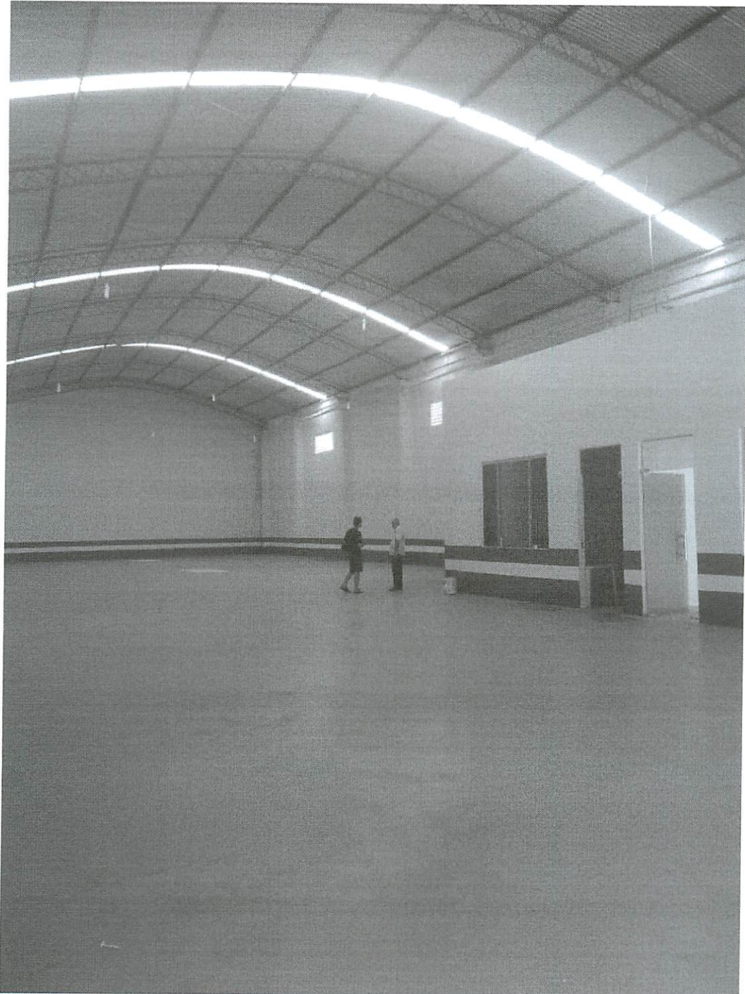
Foto 04 – Área interna ao Galpão.
