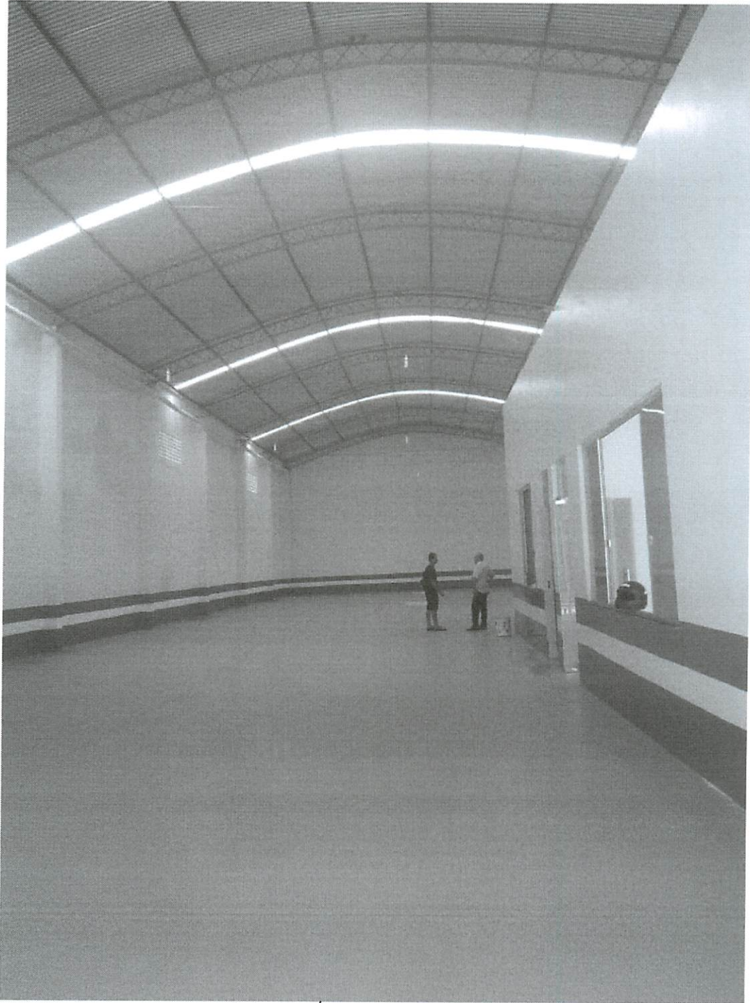
Foto 05 – Área interna ao Galpão.
