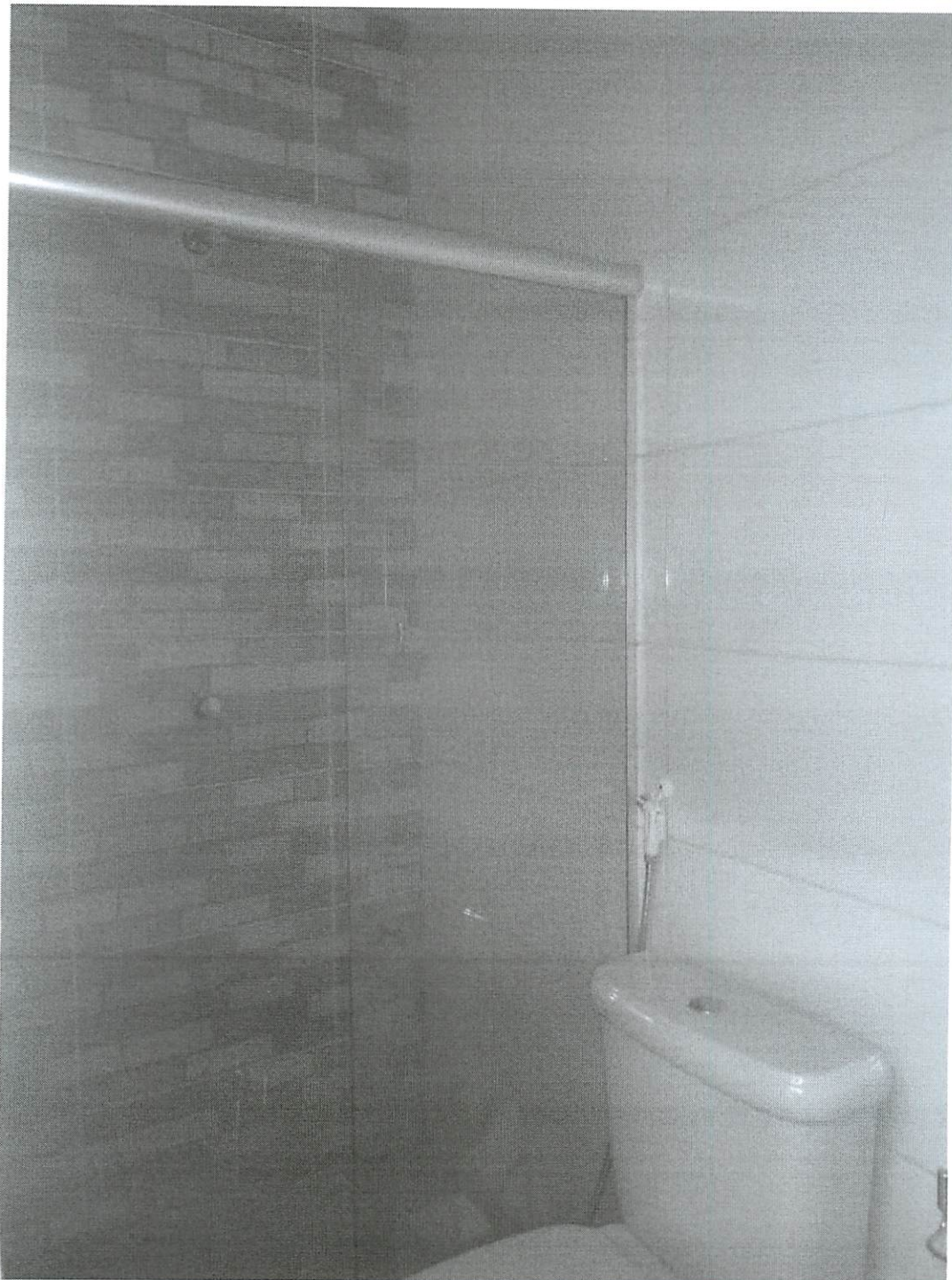
Foto 08 – Banheiro do Galpão
