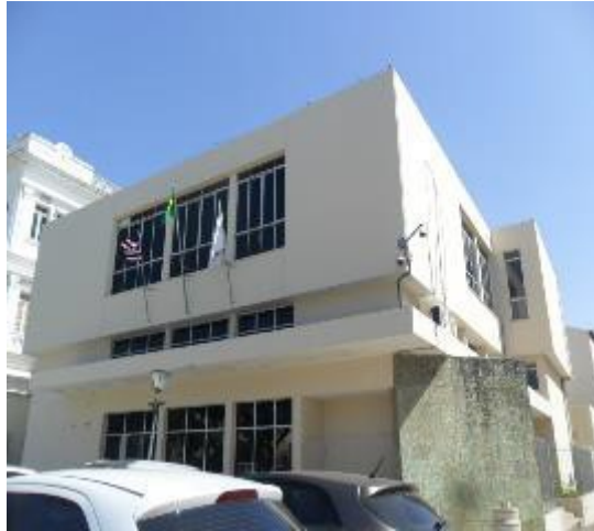
FIG. 1 - FACHADA DO IMÓVEL
