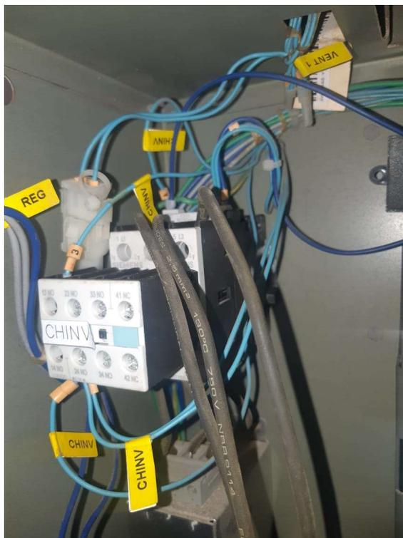
Figura 2 – Contator de Potência do Elevador 97014
