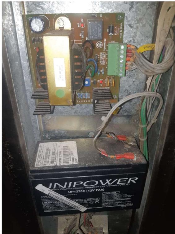
Figura 3 – Fonte da luz de emergência do Elevador 97014
