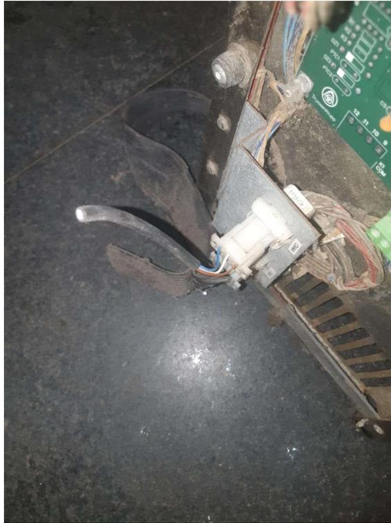
Figura 1 – Ausência de sensor magnético no Elevador 97014
