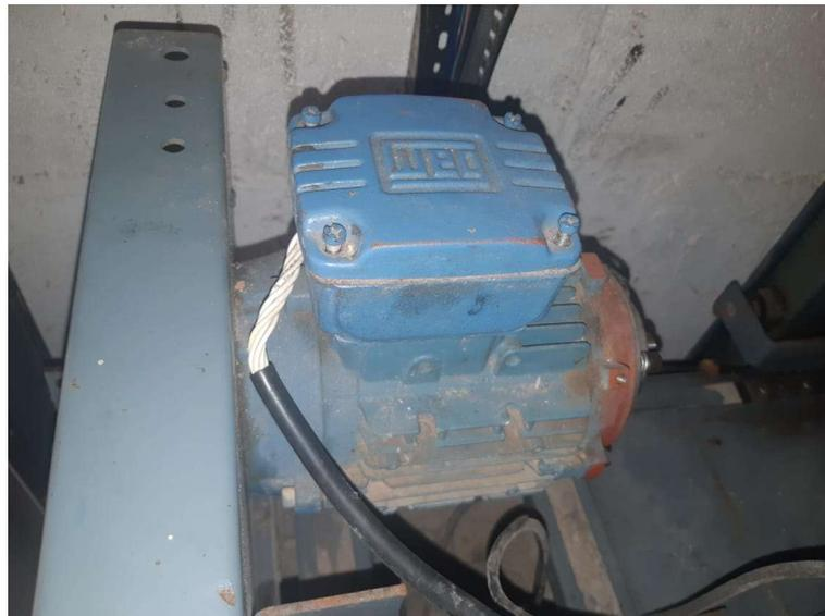
Figura 12 – Motor operador de porta do Elevador 97014
